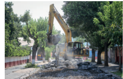
Reparación de Calles
