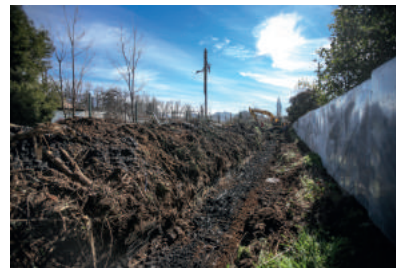
Limpieza de Canales
